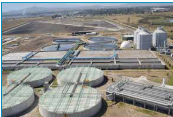
Biogas plant, El Ahogado, Jalisco.
