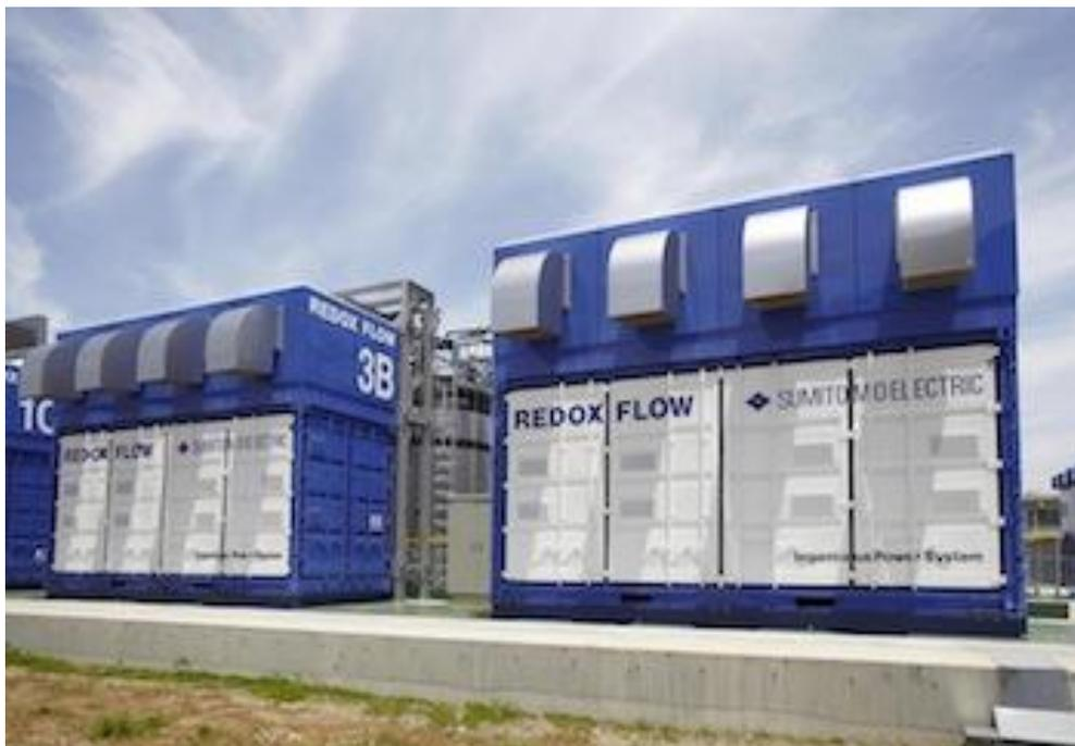
**Fig. 11.** Ejemplo de una batería de flujo redox de vanadio, desarrollada por la firma japonesa Sumitomo Electrical Industries.
