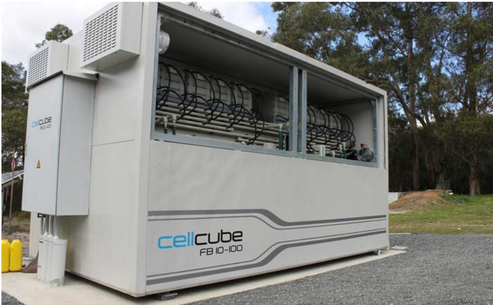
**Fig. 12.** Batería de flujo redox de vanadio, desarrollada por la empresa alemana Gildemeister, instalada actualmente en Austria.
