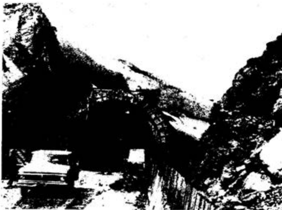
Fig. 33. Vista del tunel artificial.
