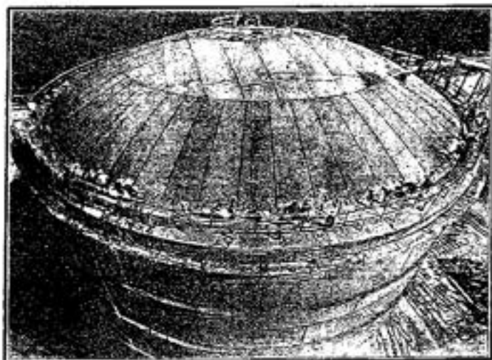
Fig. 14. Vista del tanque criogénico.
