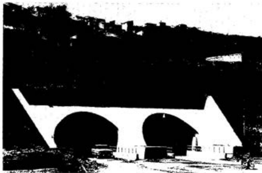
Fig. 27. Vista de uno de los portales.
